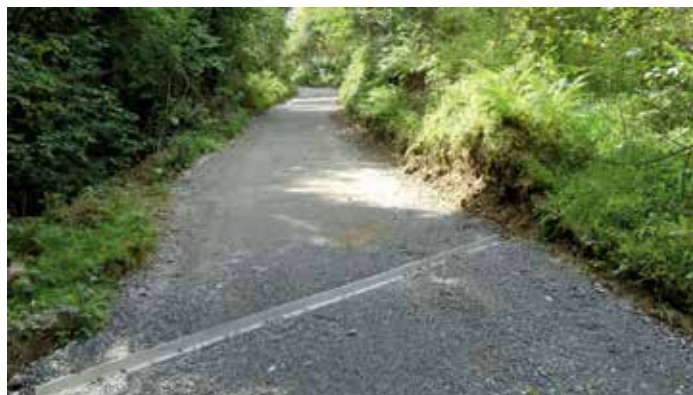
Modernizacja drogi rolnej w Miliku
