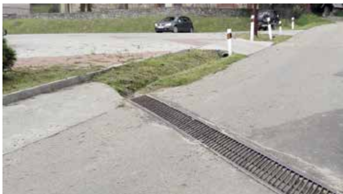
Wykonanie oraz montaż kraty przepustu poprzecznego na drodze gminnej w Żegiestowie
