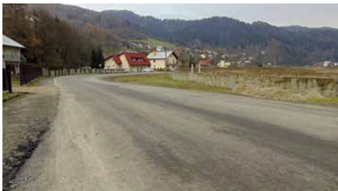
Odbudowa drogi gminnej ul. Leśła
