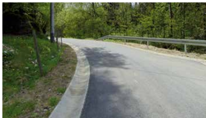
Remont drogi gminnej w Jastrzębiku
