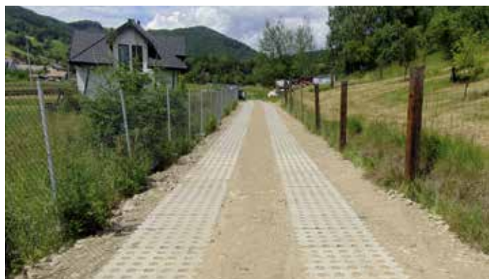
Utwardzenie drogi gminnej płytami żelbetowymi ażurowymi w Szczawniku wzdłuż Orlika
