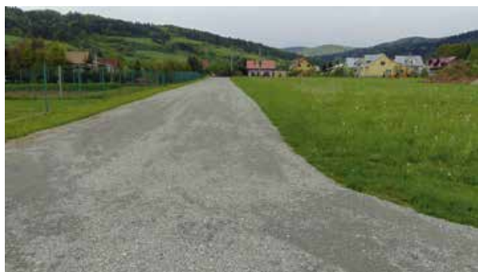
Wykonanie podbudowy na drodze gminnej w Powroźniku
