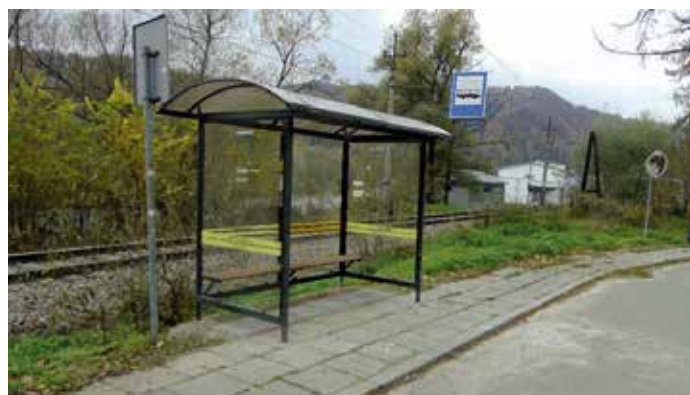
Montaż przystanku autobusowego ul. Lipowa
