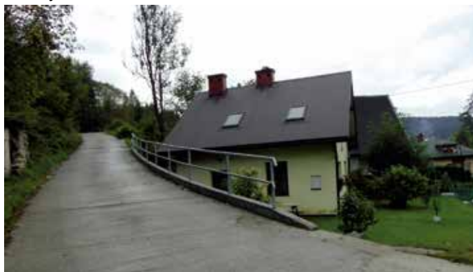
Wykonanie murka odwadniającego wraz z barierą ochronną przy drodze gminnej w Andrzejówce
