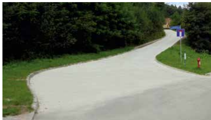
Odbudowa drogi na ul. Zielonej
