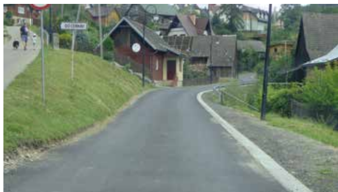
Odbudowa drogi w Andrzejówce
