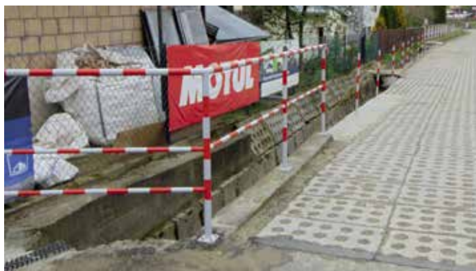
Wykonanie słupków i barier zabezpieczających ciek wodny w Powroźniku
